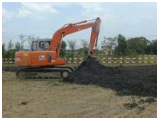
河川整備で発生した土を 公園整備に利用
