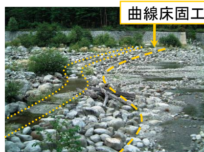
巨石を用いた曲線床固工
