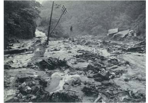
上割新宮川発電所付近の惨状
