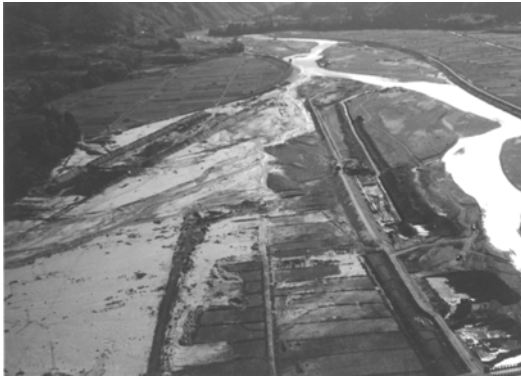
新宮川合流点の氾濫状況
