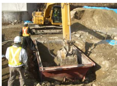
①土砂とセメントの混合
