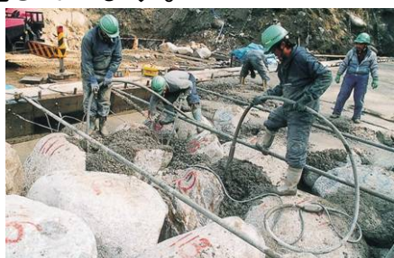
玉石打設状況
