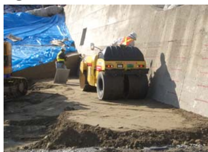
④転圧・締固め
