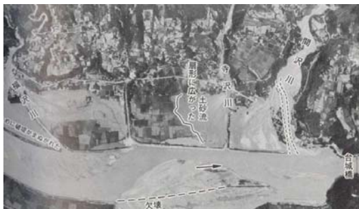
竜西流域下流の天竜川沿いの被災状況
