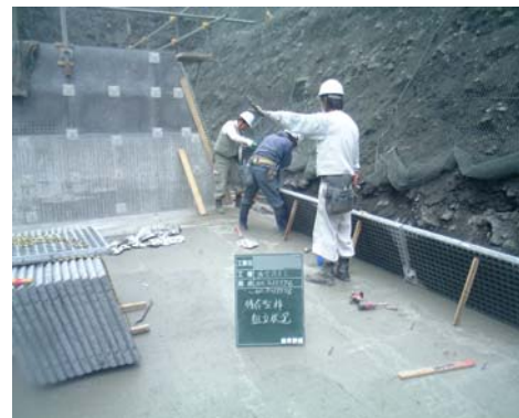
残存型枠の組立て状況
