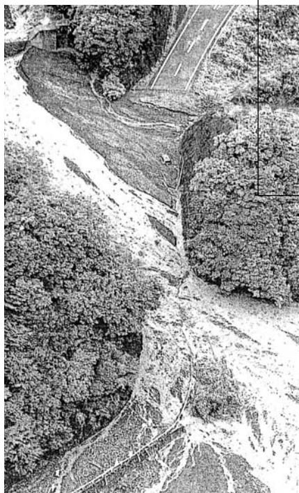
寸断された主要地方道梅ヶ島温泉昭和線
