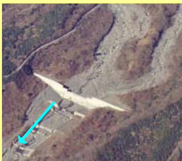
大島砂防えん堤(昭和53年撮影)
