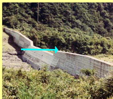
大島砂防えん堤(昭和56年撮影)
