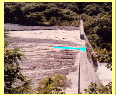
大島砂防えん堤(昭和57年撮影)
