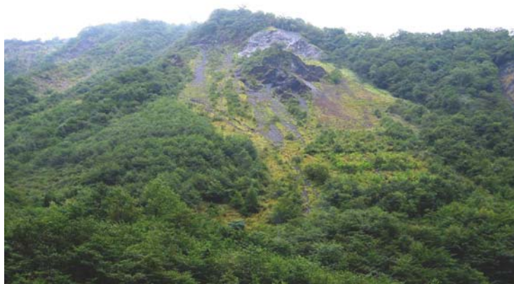
現在の大谷山腹工
