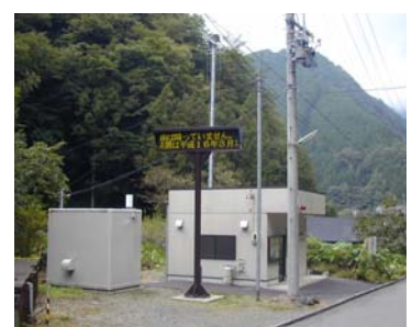
土石流予警報システム
