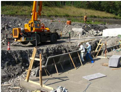
残存型枠の組立て状況
