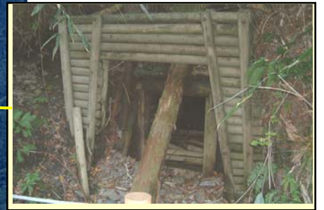
日影沢金山坑道跡
