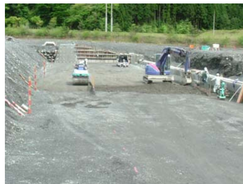
転圧・締固め
