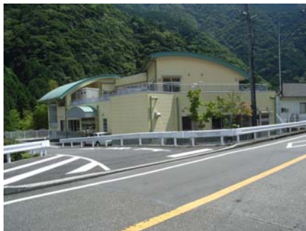
災害時要援護者施設
