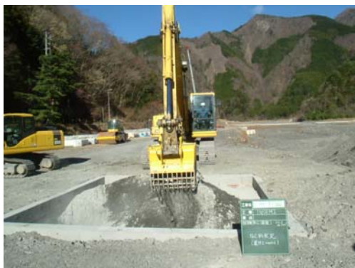
土砂とセメントの配合
