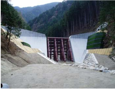
木曾川梨子沢第1砂防えん堤(透過型)
