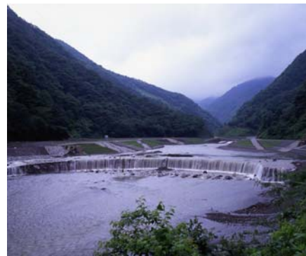
揖斐川ナンノ谷床固工群
