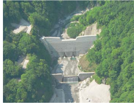
天竜川飯島第6砂防えん堤(不透過型)
