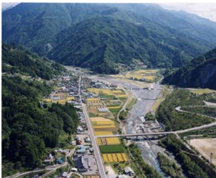
天竜川大河原床固工群
