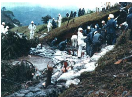
堤防の一部侵食に対する応急工事の状況 (昭和57年8月洪水:静岡市福田ヶ谷地先)
