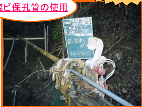
横ボーリング工の施工状況
