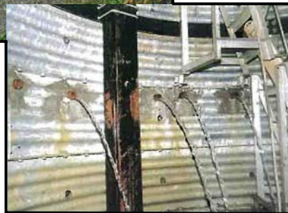
集水井工全景及び内部の集水状況
