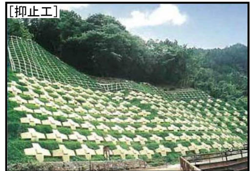
アンカー工・法枠工
