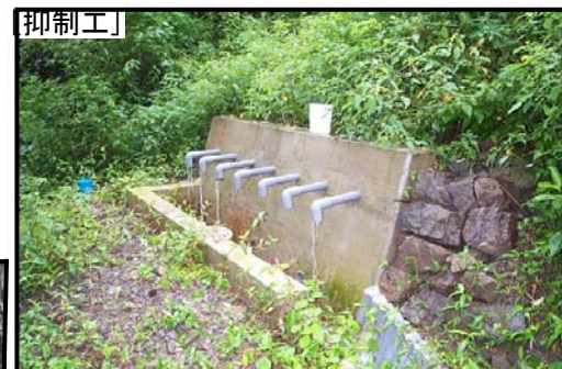
横ボーリング工による排水の状況
