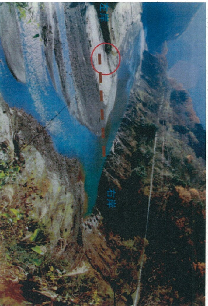
堆砂により埋没した鬼姫生橋(平成 11 年)
