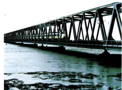
昭和 50 年 8 月洪水 (戦後最大規模) JR新幹線揖斐川橋
