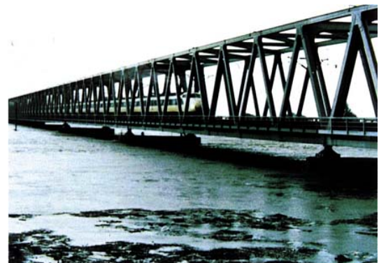
昭和 50 年 8 月洪水(戦後最大規模) JR新幹線揖斐川橋
