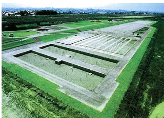
支川浄化施設(境川)
