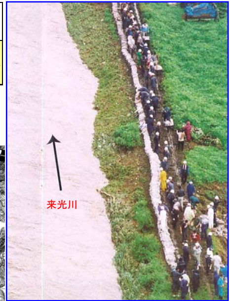
かんなみ かみさわ ①函南町上沢地区での 溢水による水防活動 (平成10年8月洪水)
