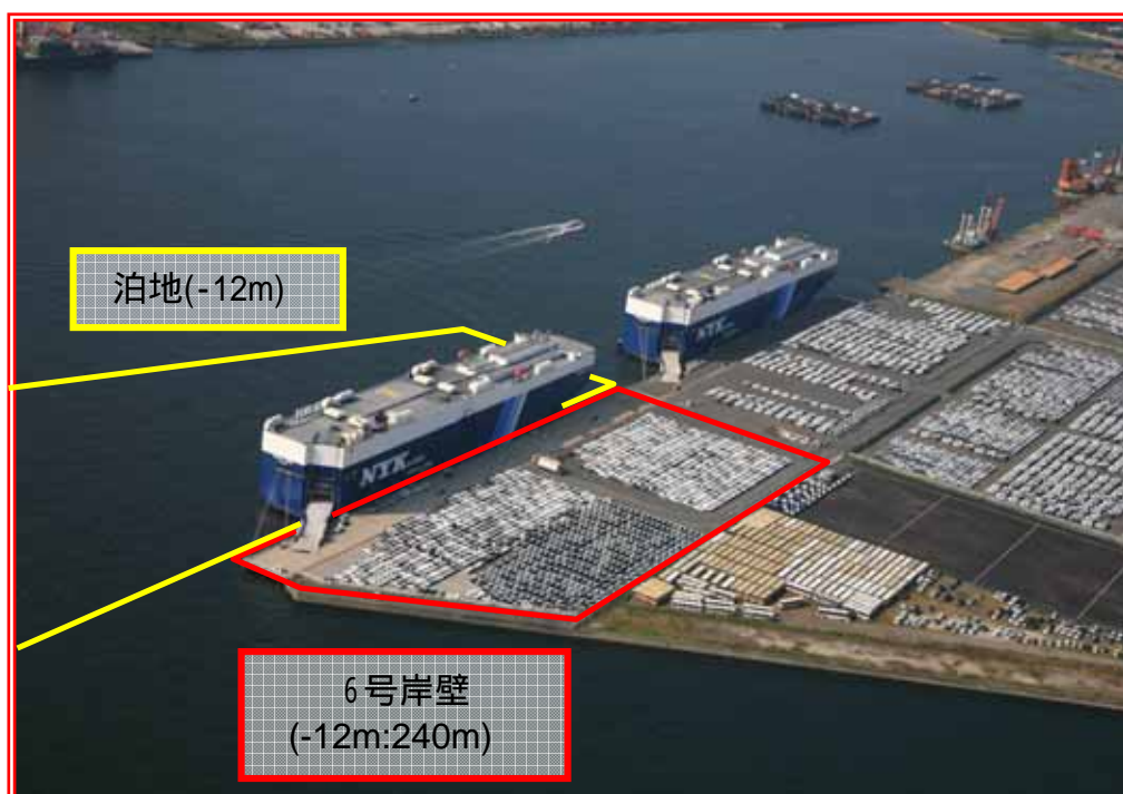
図 - 1 2 名古屋港弥富ふ頭多目的国際ターミナル整備事業
