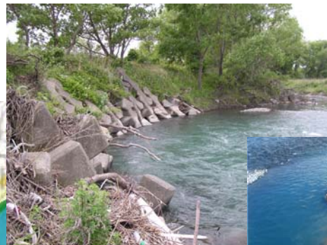
護岸の被災状況
