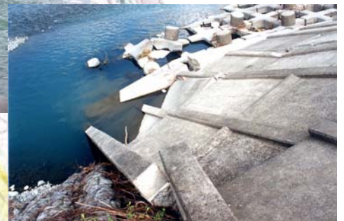
護岸の被災状況
