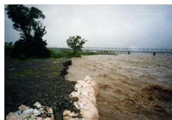
平成27年9月洪水の被災状況 (大柳地先)
