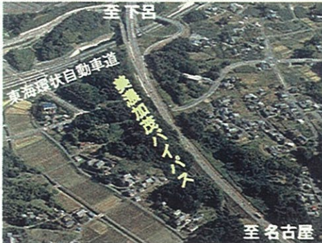
写真：供用済み区間の状況（美濃加茂IC付近）
