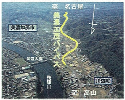
終点側(加茂郡川辺町)から起点側(美濃加茂市)方面を望む
