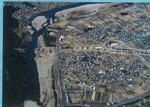
■美濃関JCT現場状況
