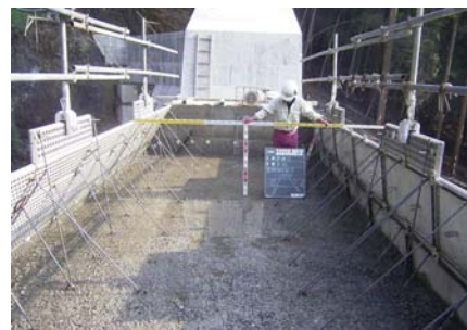
残存型枠を利用した整備
