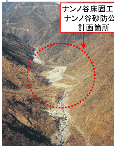
ナンノ谷床固工群施工前
