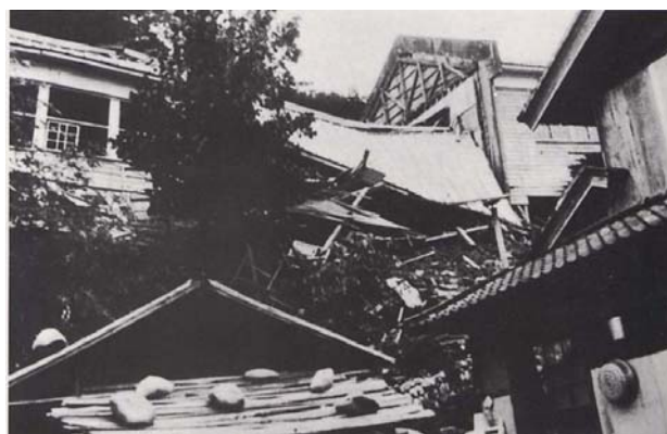
倒壊した徳山小学校（旧藤橋村） (出典：越美山系災害史)
