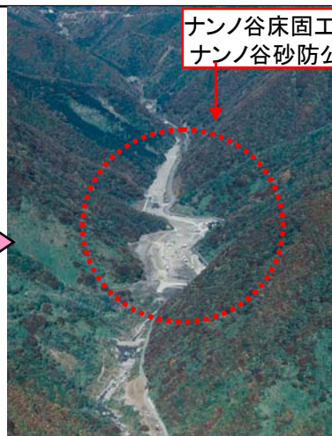
ナンノ谷床固工群施工後
