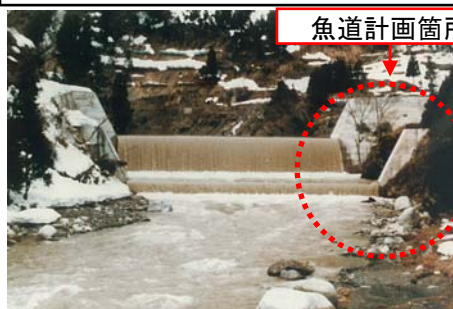
坂内砂防えん堤(魚道設置前)
