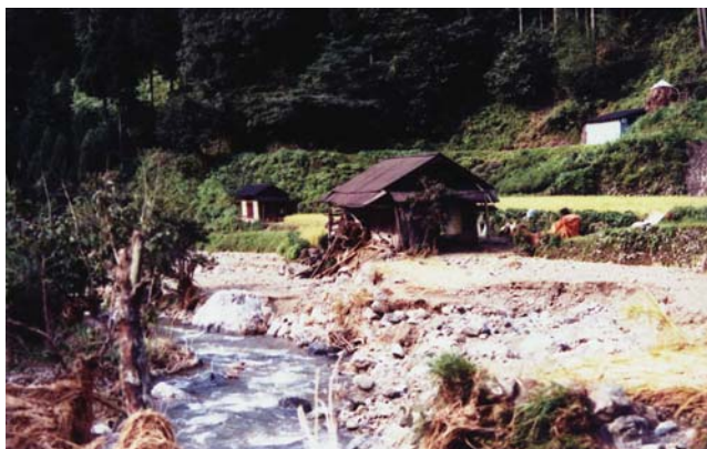
高知川沿いの被災状況（旧久瀬村）
