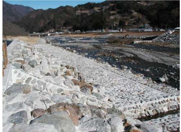
2) 護岸工の基礎工にプレキャストコンクリート基礎を使用することや中詰め材に現地にて発生するコンクリート塊や、石材を使用することで、コンクリート量の低減及び工期を短縮しています。従来工法の現場打基礎工に比べ縮減率 約24% (約120万円/270m) のコスト縮減を図っています。
