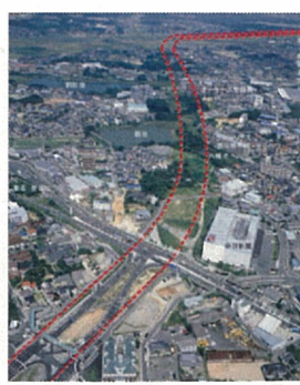
③豊田市美山町上空より 豊田市北部地域方面を望む
