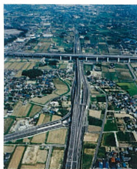
①起点部付近から 豊田IC方面を望む
