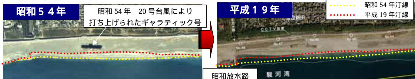
富士海岸の侵食状況
