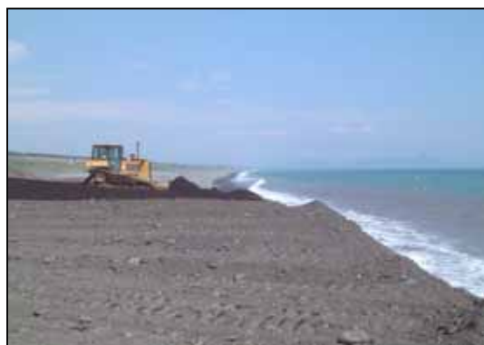
吉原工区における養浜工の施工状況
