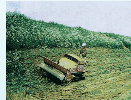
堤防除草作業状況
