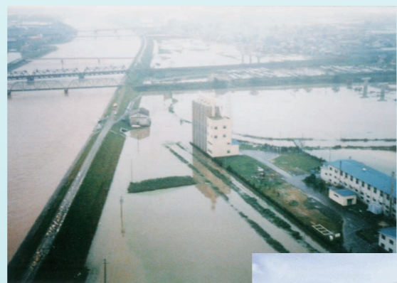
昭和57年8月洪水 小坂井排水機場 付近の浸水状況
