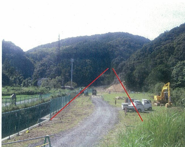
山切りが進む工事実施状況 トンネル起点側 (下地地区)
