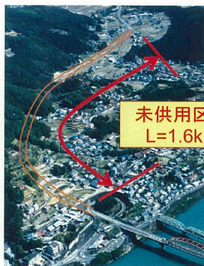
トンネル終点側 (上地地区)
