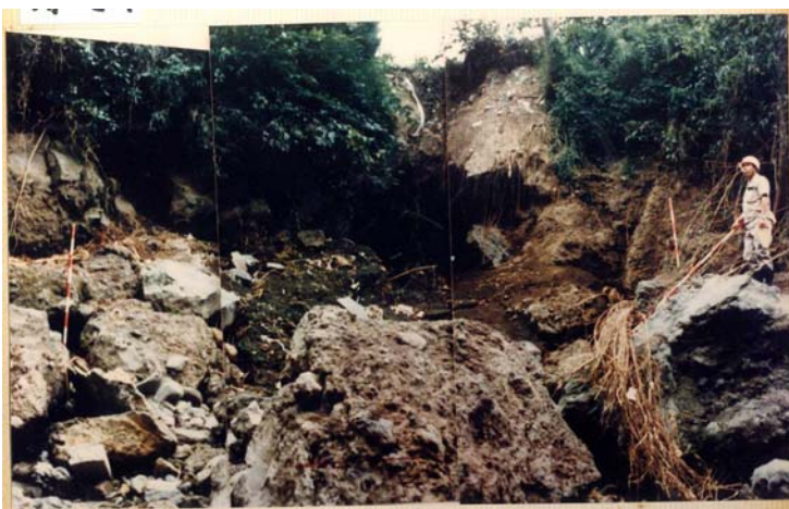
赤淵川の荒廃状況
