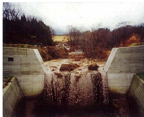
平成4年、富士山西麓の栗ノ木沈砂地における雪代捕捉状況
