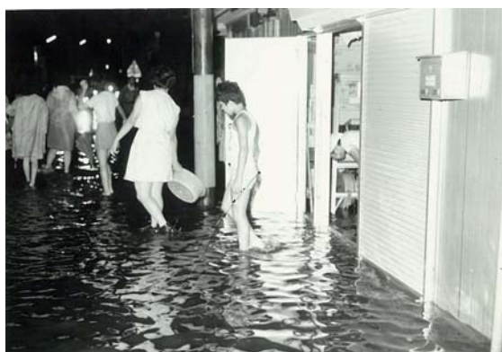
吉原本町通の被災状況
