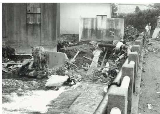
原田地区の被災状況
