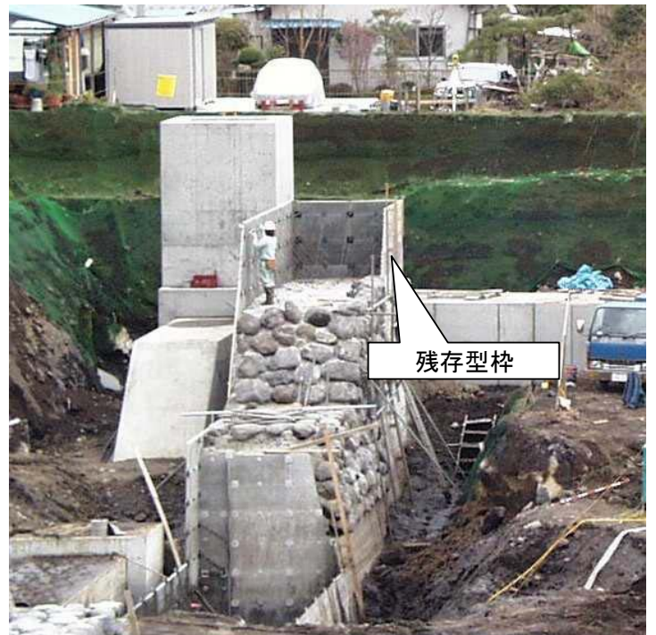
残存型枠を利用した整備
