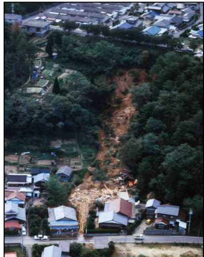
崩壊した斜面
