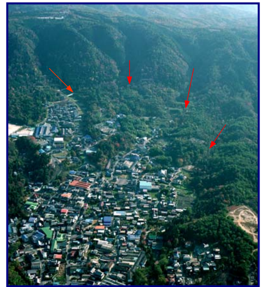
土石流危険溪流に囲まれた保全対象 (笠原川支川平園川流域)
