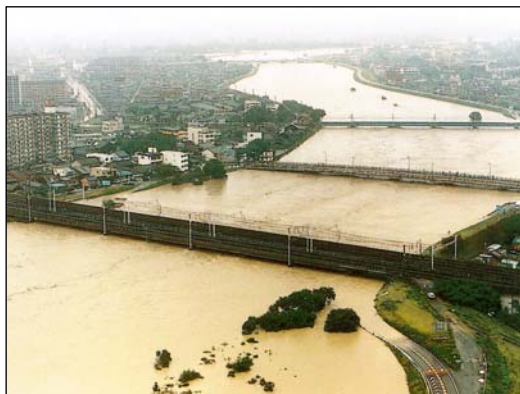
東海豪雨時の庄内川 「平成12年9月東海豪雨 建設省中部地方建設局・愛知県」
