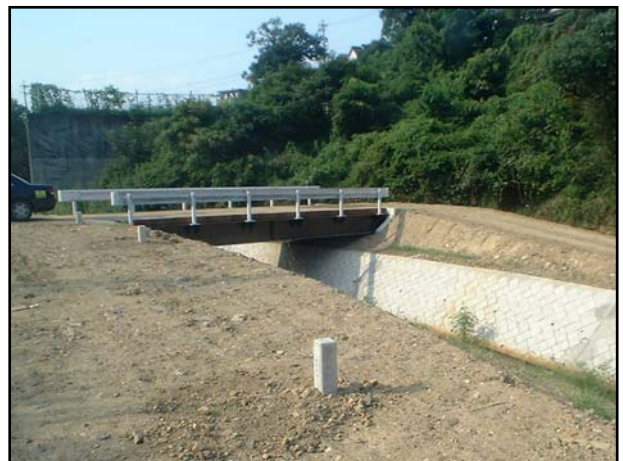
仮設材を再利用した仮橋の整備
