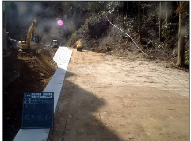
他工事の掘削残土を利用した盛土の整備
