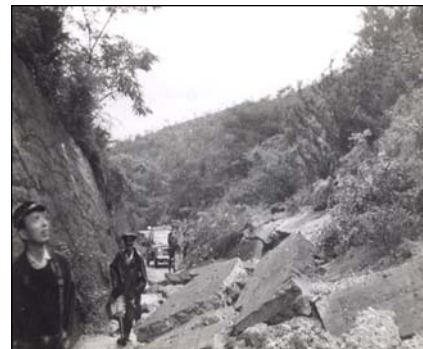
通行止めになった県道
