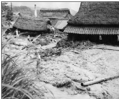
土砂流出により埋まった家屋
