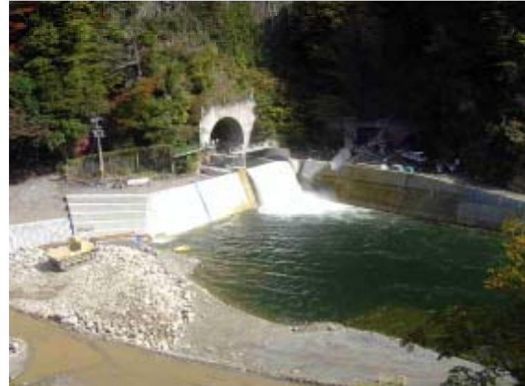
ダム下流直下2号仮排水路放流状況(11月9日撮影)
