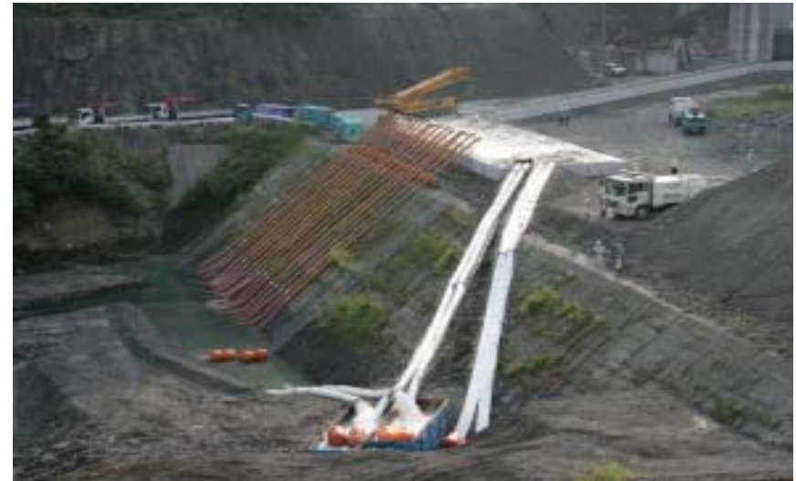
河川維持流量補給のための仮設ポンプ稼働開始
