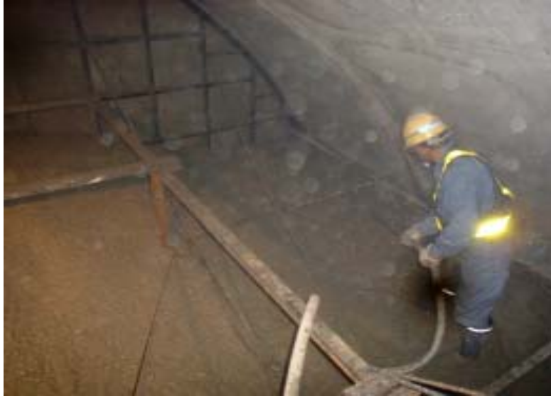
仮プラグコンクリート打設状況(10月6日撮影)
