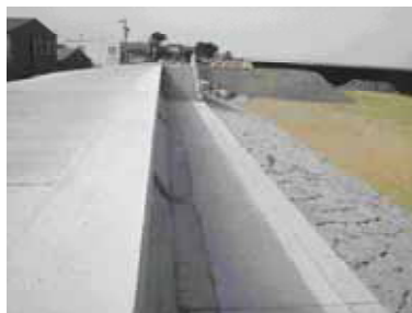
地域住民の意見を取り入れ整備された堤防(整備後)
