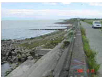
空洞化や浜の侵食が著しく老朽化した堤防の状況（整備前）
