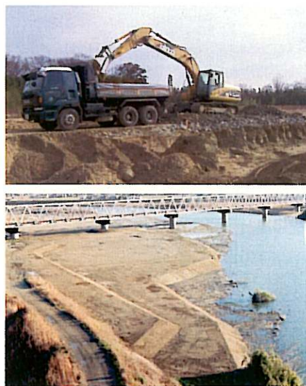
高水敷の掘削状況（雲出川）
