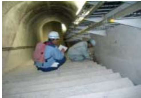
堤体監査廊内での計測
