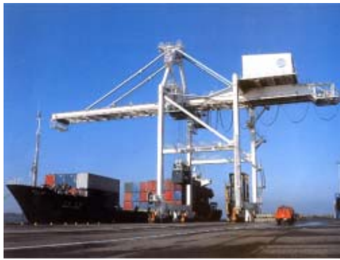
ガントリークレーンの整備
