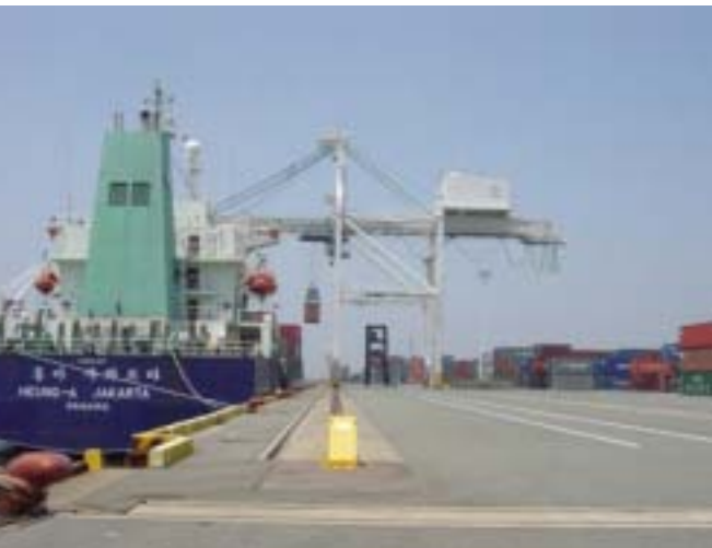
コンテナ荷役状況
