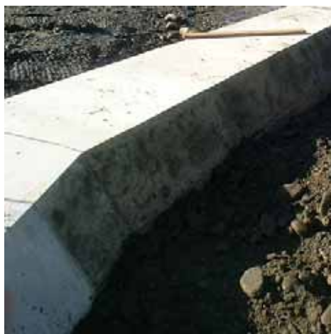
現場打法枠基礎
