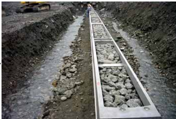
プレキャスト基礎の中詰材として コンクリートガラを利用
