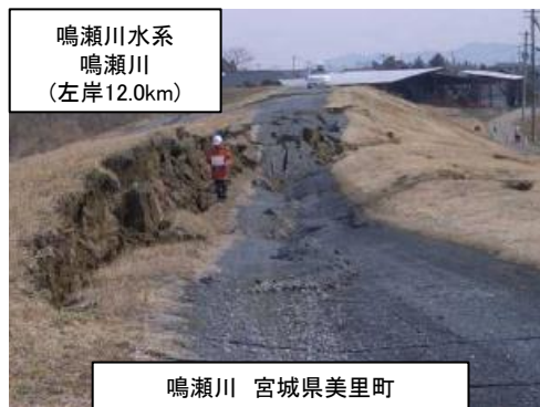
平成23年3月東北地方太平洋沖地震による堤防の被災状況
