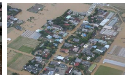
平成19年9月洪水(台風9号) 伊豆の国市長崎地区
