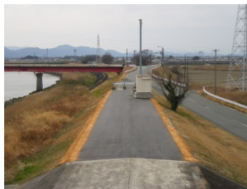
宮川左岸4.4k付近
