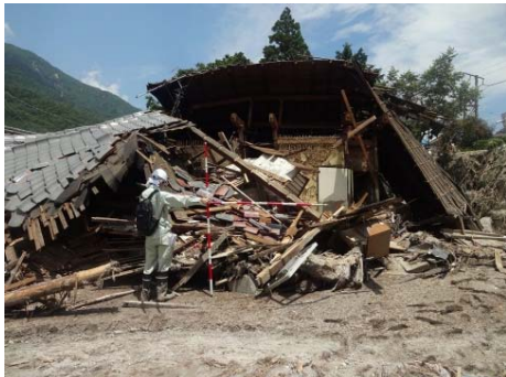
土石流に破壊された人家
