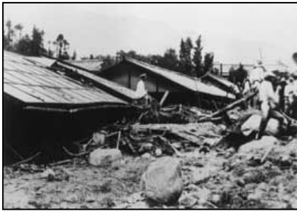
中津川市内の被災状況
