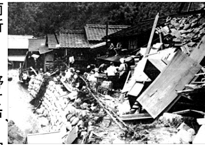
土石流に破壊された人家
