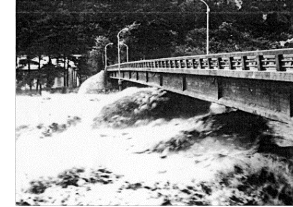
南木曾橋の主桁にせまる濁流
