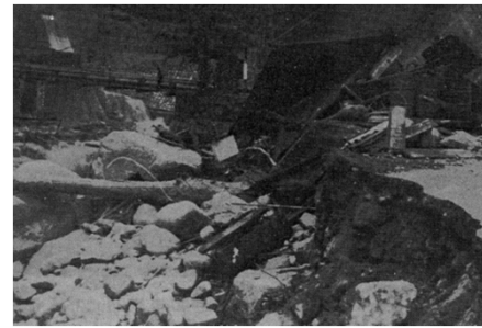
川上地区の被災状況
