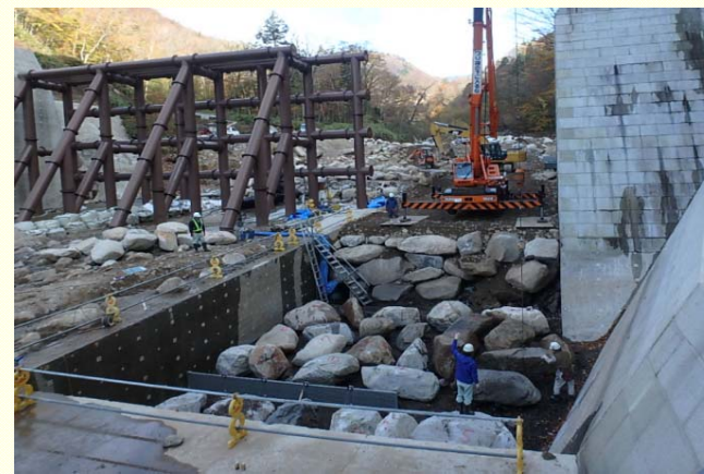
中津川第11砂防堰堤の事例
