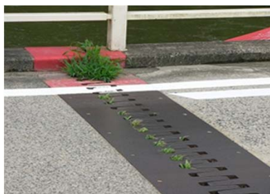
(従来形式) 鋼製フィンジョイント
