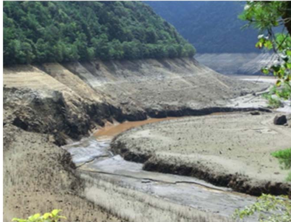
枯渇する宇連ダム (平成25年9月)
