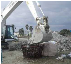
現場発生材の袋詰め
