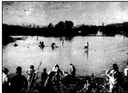
台風13号(S28)で堤防決壊により浸水した津市
