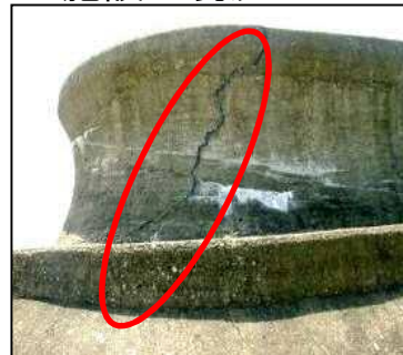
老朽化によるひび割れ
