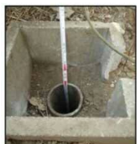
【地下水位確認】
