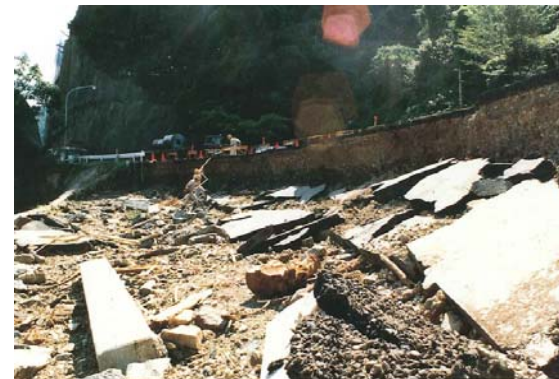
坂祝町内 被災状況
