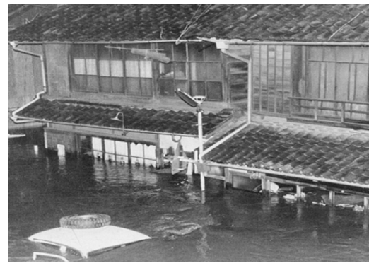
美濃加茂市内 被災状況
