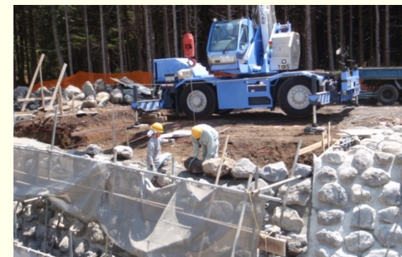
巨石張り護岸施工状況
