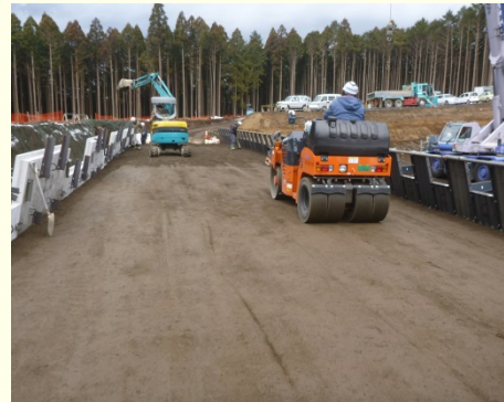
転圧・締固め
