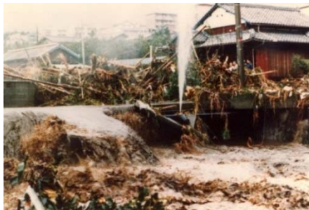
富士市天間地区の被災状況
