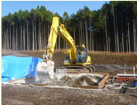
土砂とセメントの混合
