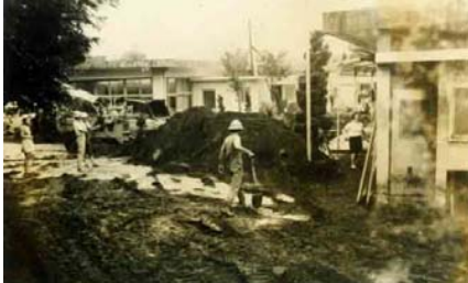
富士宮市上井出地区の被災状況
