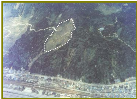
濁り沢地すべりの状況(S49.7)
