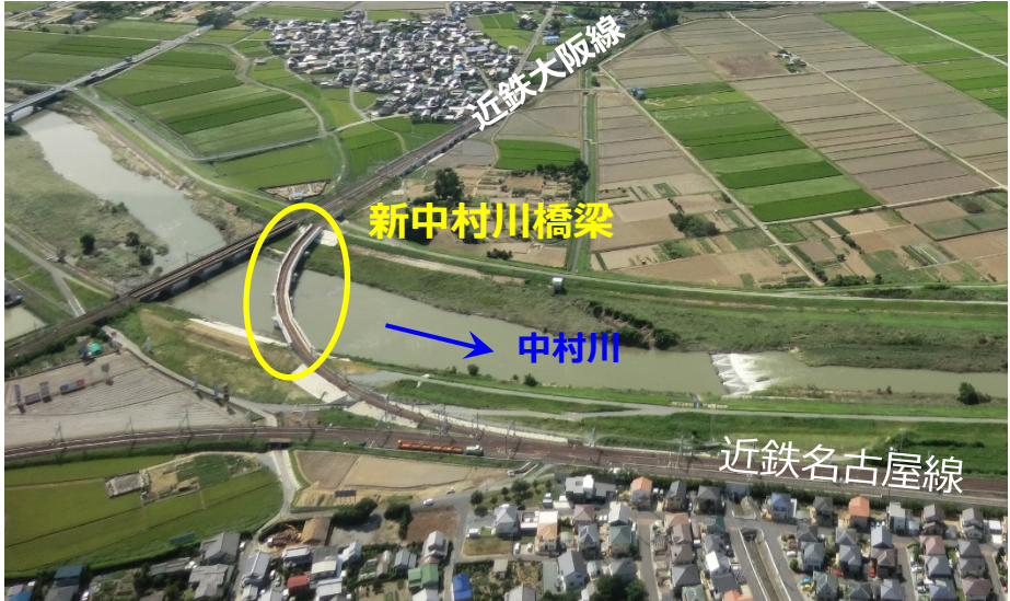
事業完了後の新中村川橋付近の状況（平成26年8月）
