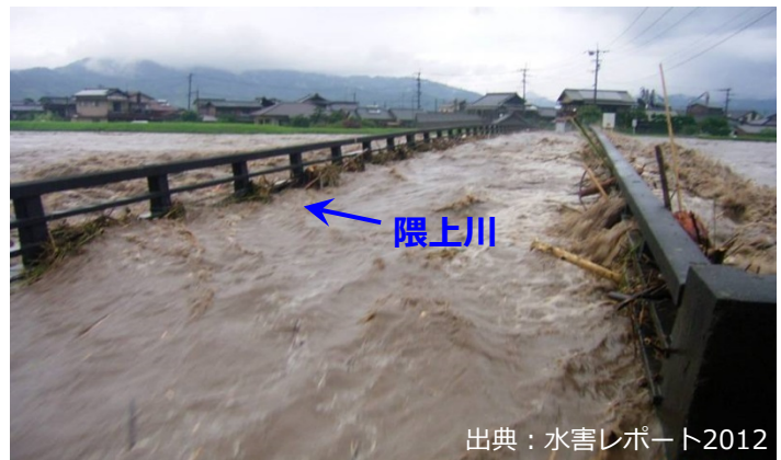
平成24年7月に九州地方で発生した豪雨時の橋梁部における堰上げ状況 出典：水害レポート2012
