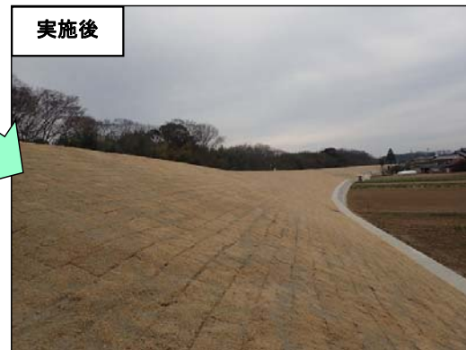
堤防補強状況 (H28年度完成) 橋尾地区
