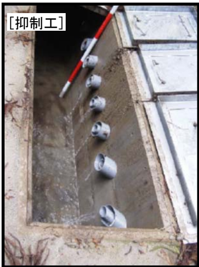
横ボーリング工による排水の状況
