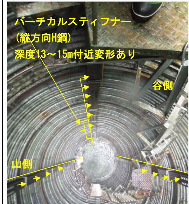
既設集水井(WA-8)変形状況
