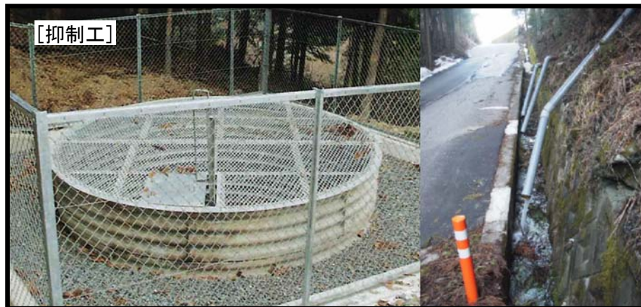
集水井工全景及び集水井(流沫)からの排水状況
