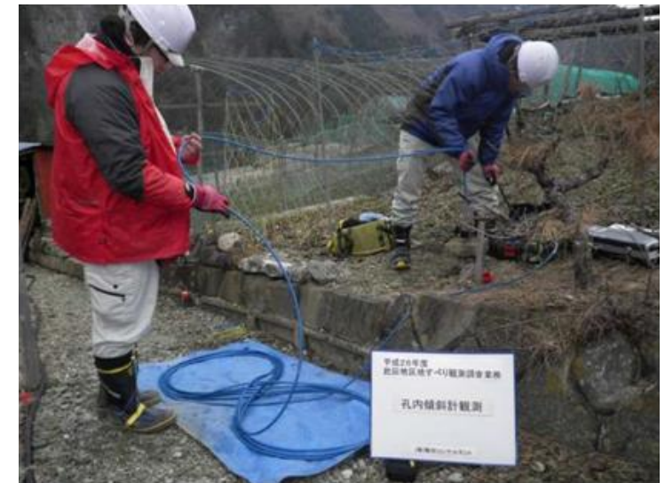
地すべり監視(孔内傾斜計観測)状況
