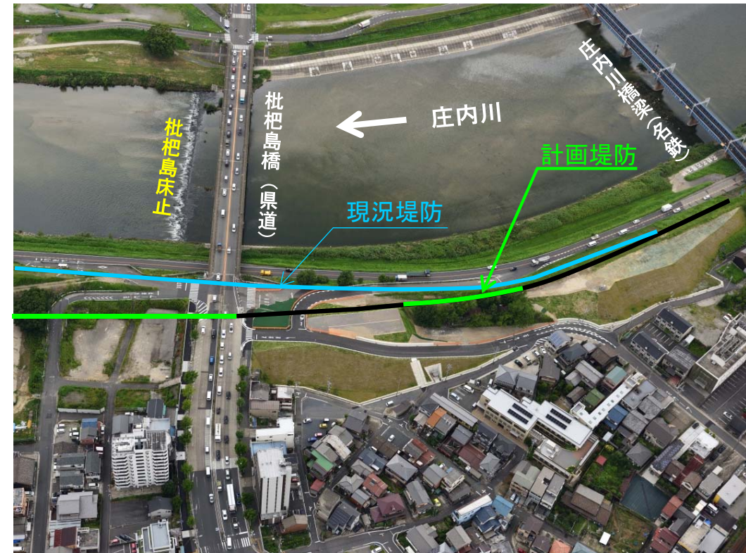
築堤状況(左岸) (H29.7撮影)
