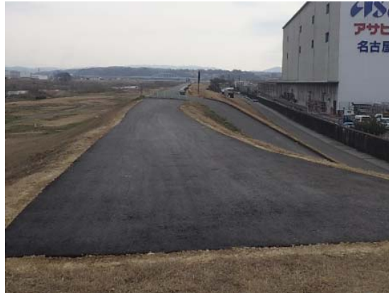
危機管理型ハード対策(天端保護工) 整備状況(幸心地区) (H27年度実施)
