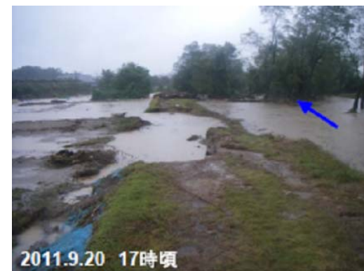
平成23年9月洪水(台風15号) 下志段味※地区の越水状況
