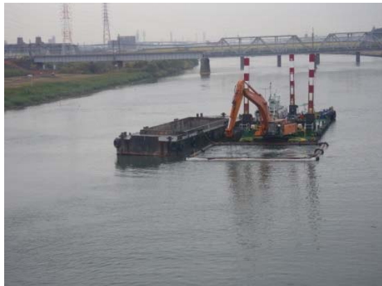
河道掘削状況(前田地区) (H28年度実施)
