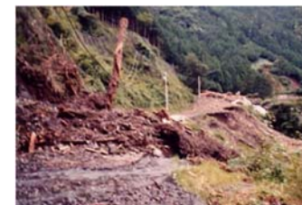
関の沢橋の被災状況
