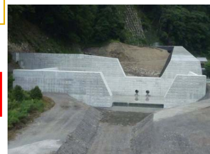
トイグチ沢砂防堰堤(H25年完成)
