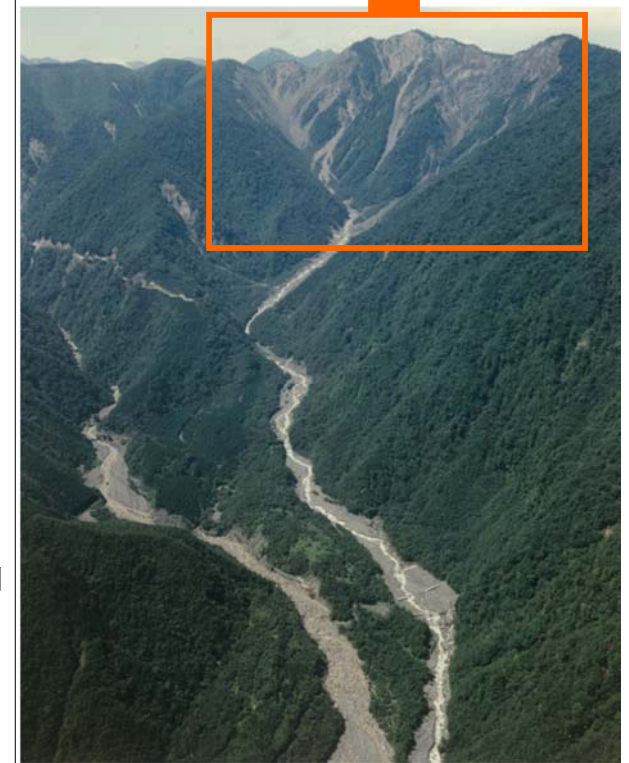
大谷崩源頭部とその下流溪床に堆積する不安定土砂
