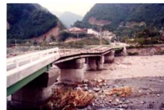
県道の欠損状況
