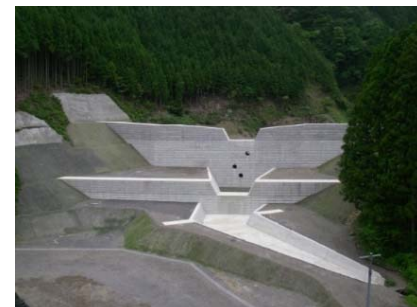
ウラの沢砂防堰堤(H24年完成)
