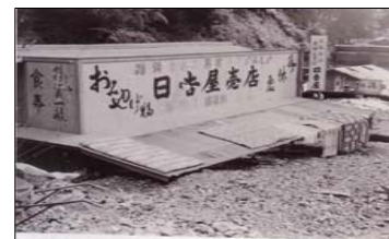
土石流により被災した梅ヶ島温泉
