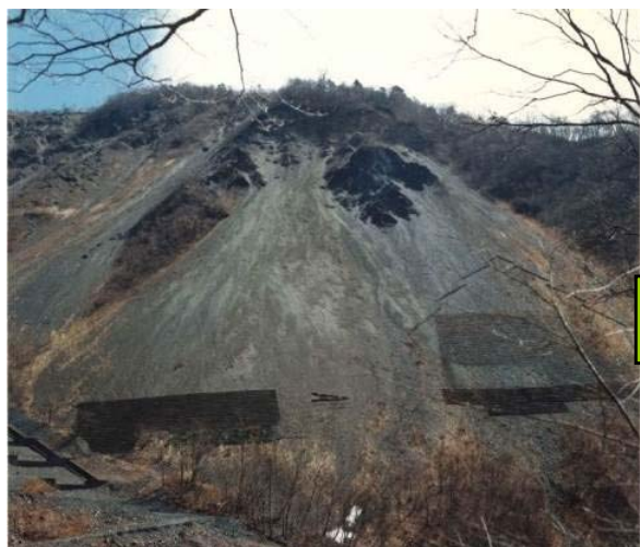
大谷山腹工(昭和62年撮影)
