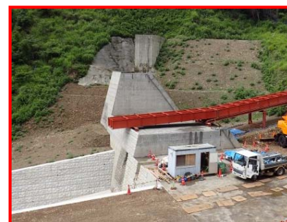
杉ノ木沢堰堤(H29完成予定)
