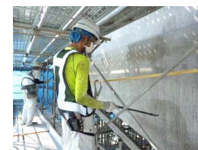
写真-剥落防止対策施工 (表面含浸剤)
