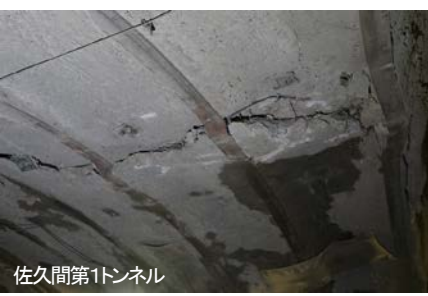
■支保工の変状
