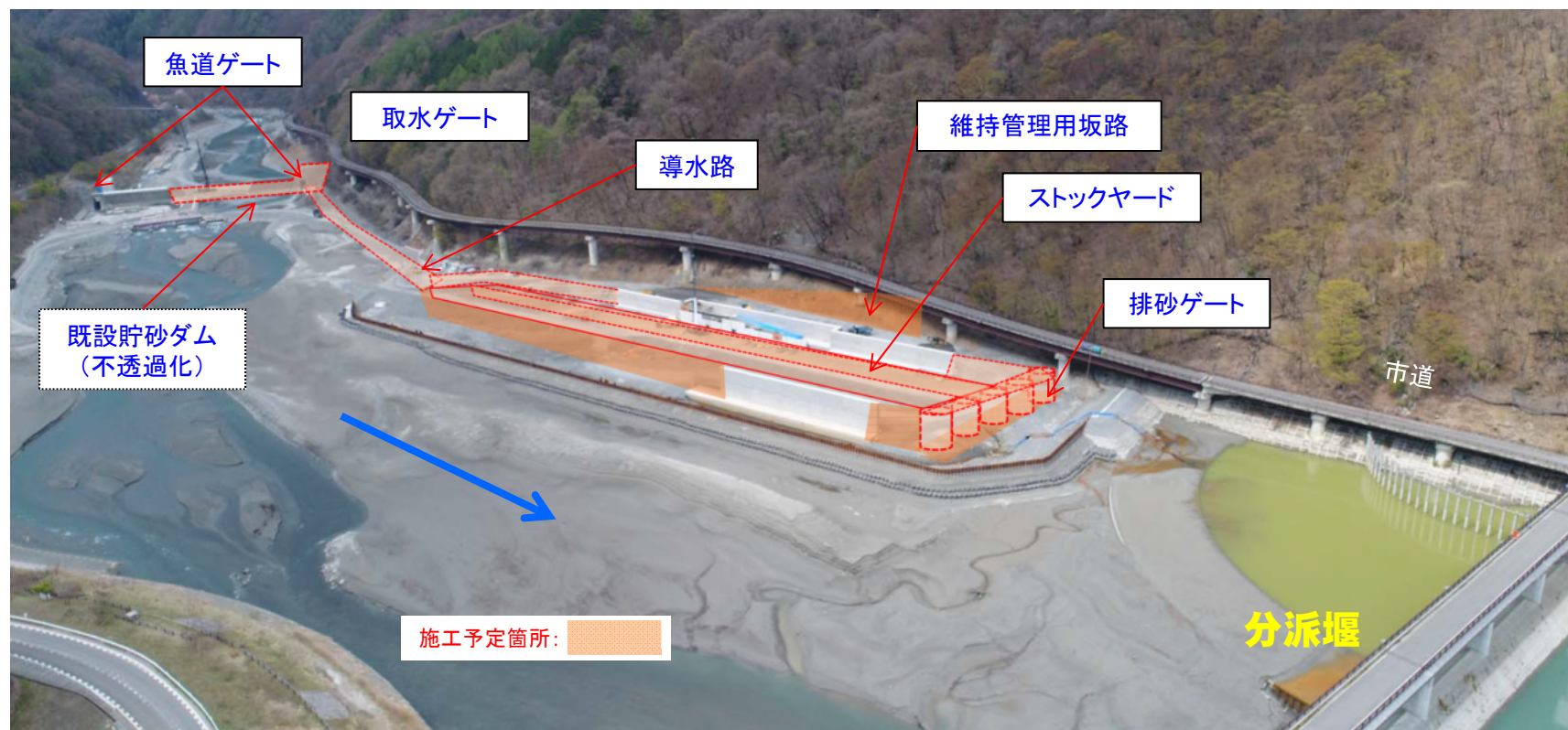
湖内堆砂対策施設施工状況(平成29年5月現在)
