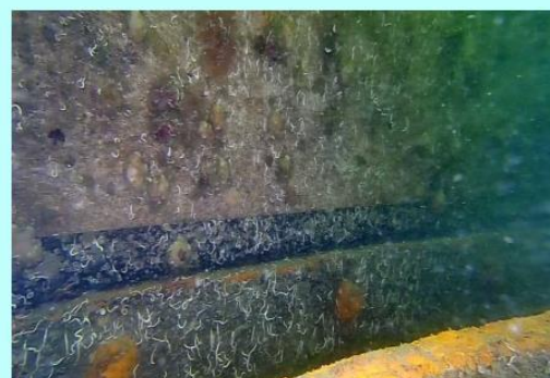
水中部の映像（自立式汚濁防止膜ウエイト部）
