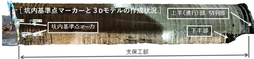
[坑内基準点マーカーと3Dモデルの作成状況]
