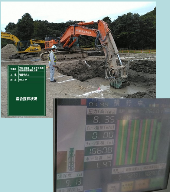
改良深度も表示され、施工履歴データとして記録される
