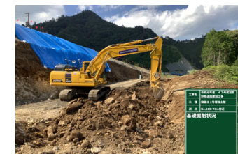
擁壁基礎の床堀（丁張りなし）
