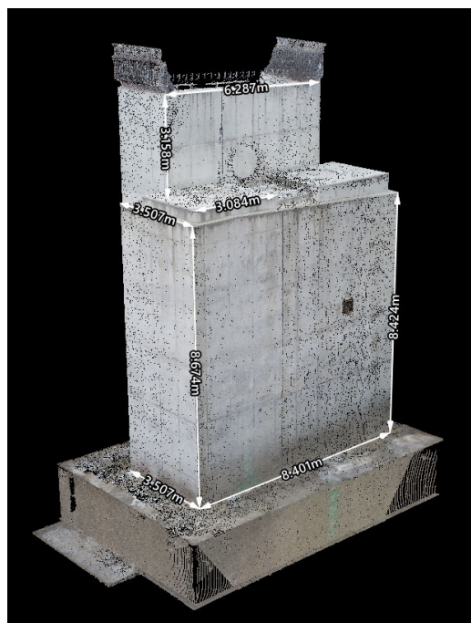
(今回)点群データによる机上計測
