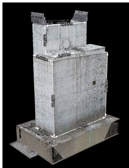
点群データによる机上計測
