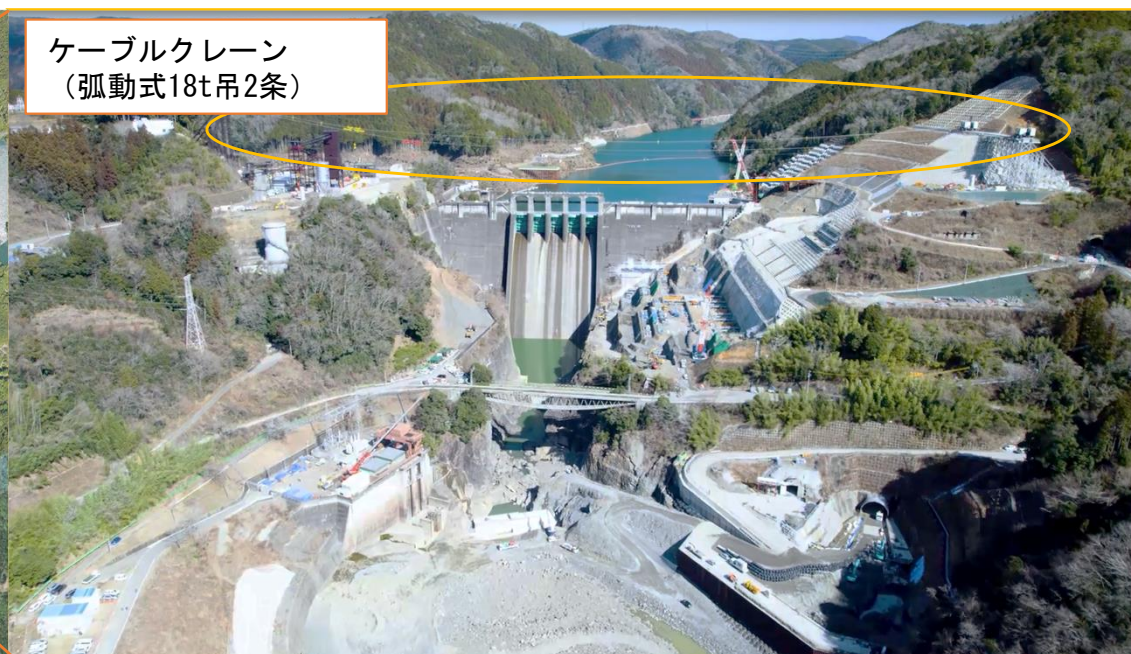
現場状況写真（下流から上流をみる）
