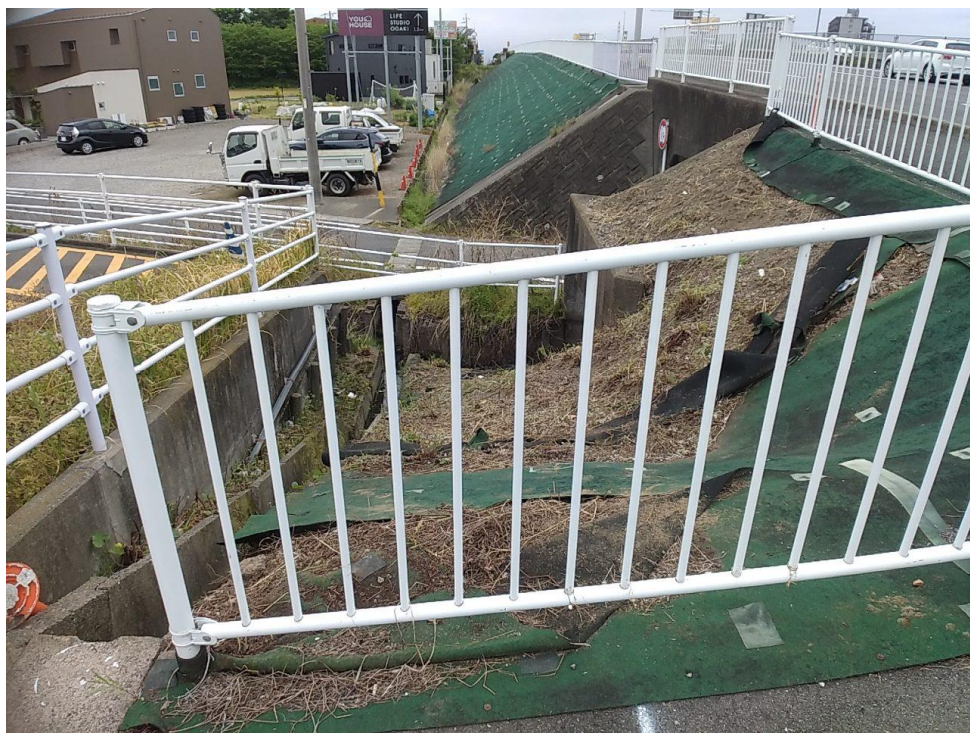
＜防草シートの劣化や破損箇所から雑草が繁茂している事例＞
