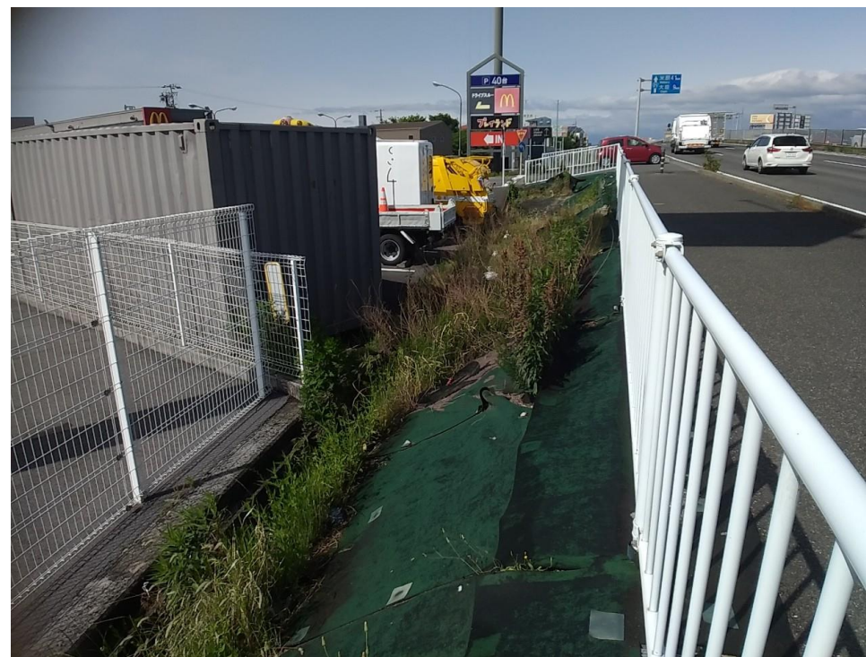
＜防草シートの劣化や破損箇所から雑草が繁茂している事例＞
