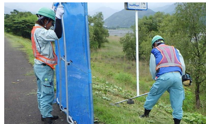
肩掛式(飛石防護有(2割勾配より急な法面))
