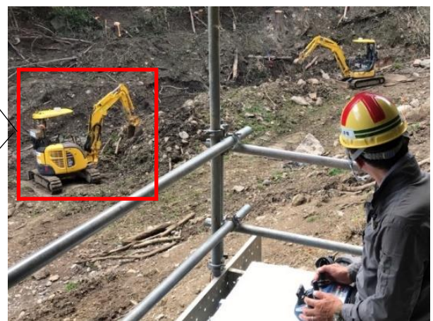
熱海市土砂災害での復旧作業状況
