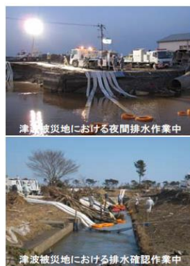
津波被災地における排水確認作業中
